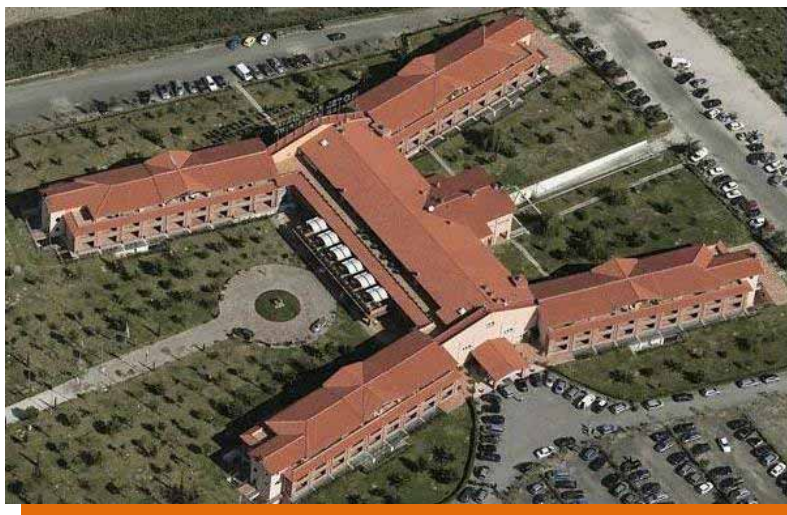
Fig. 5.6 – Struttura dell'hotel; dal corpo centrale si dipartono gli altri corpi denominati "zone"
